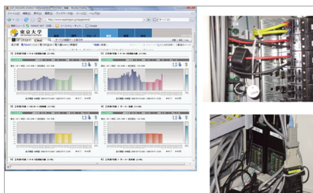
図5 電力使用量リアルタイムモニタシステム
